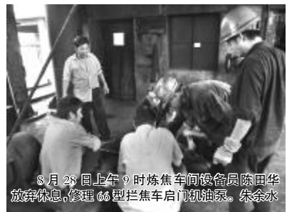
8月28日上午9时炼焦车间检修员陈国华放弃休息,修理66型拦车启门机油泵。朱余水
